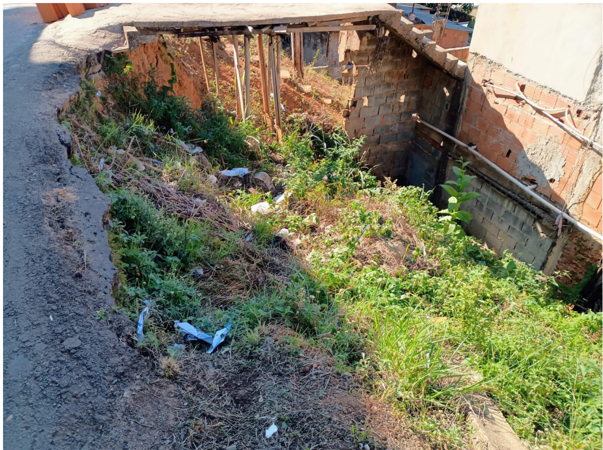
Imagem 2: Trecho desmoronado da via sem guia de calçada.
