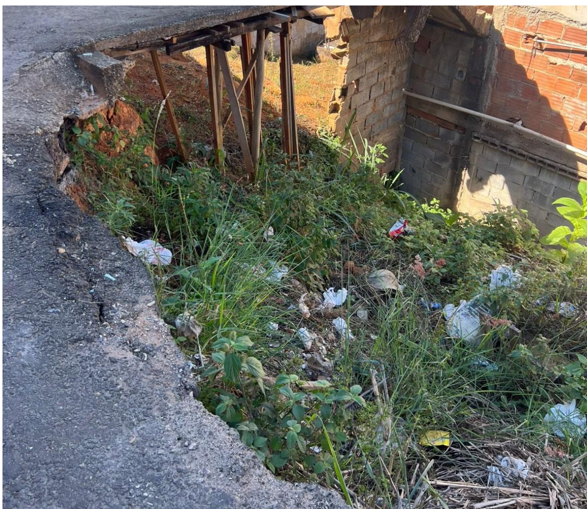
Imagem 4: Detalhe do buraco em frente ao imóvel e da ausência de meio fio na via pública .
