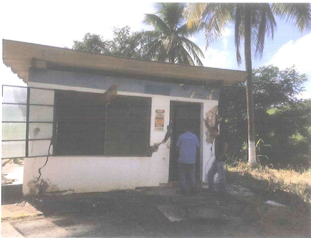
Edificação passando por obras de recuperação e afastamento de risco.
